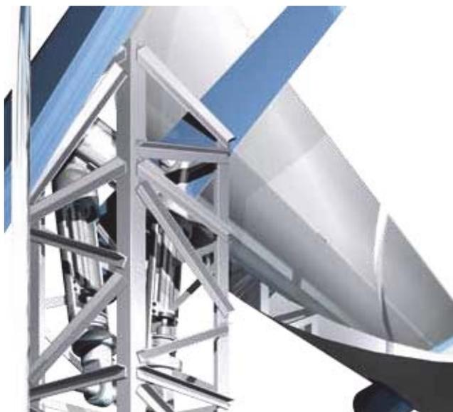
Centrale solaire à capteurs cylindro-paraboliques
