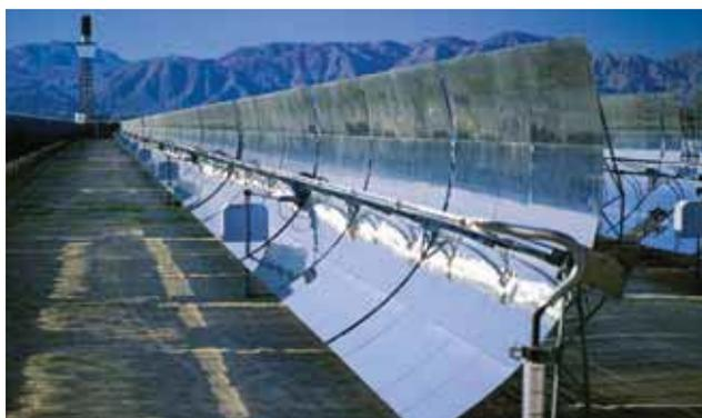
Centrale solaire à capteurs cylindro-paraboliques
